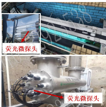
污水紫外消毒剂量验证现场（上图）和研发的饮用水消毒设备（浙江临安花戏水厂，下图）
