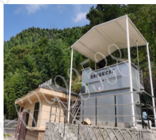
左图：库伦旗三家子学校装配式水厂（100m 3 /d，农牧地区分散式供水工程）；中图：斯里兰卡梅提哈卡村供水工程（120m 3 /d，“一带一路”饮用水技术示范）；右图：杭州市临安区楂岭水站（120m 3 /d，南部山区分散式供水工程）
