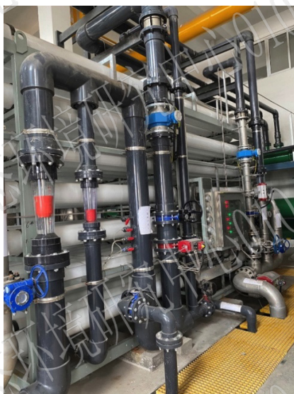
广东某电厂RO膜原位清洗修复
