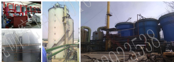
石家庄和邢台某土霉素生产废水处理系统 (800 m 3 /d, 1000 m 3 /d)
